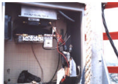
BOX 内部 上から RX コンバータ 通倍部、POW アンプ
